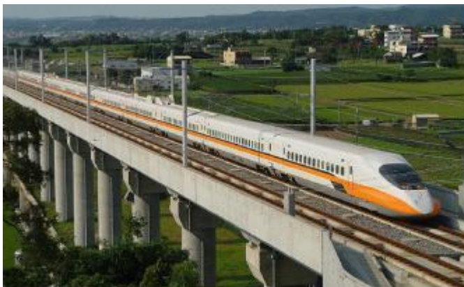
絵図2 台湾高鐵の高架橋 Wikipedia より 日本の新幹線とは橋脚の様子が異なる
